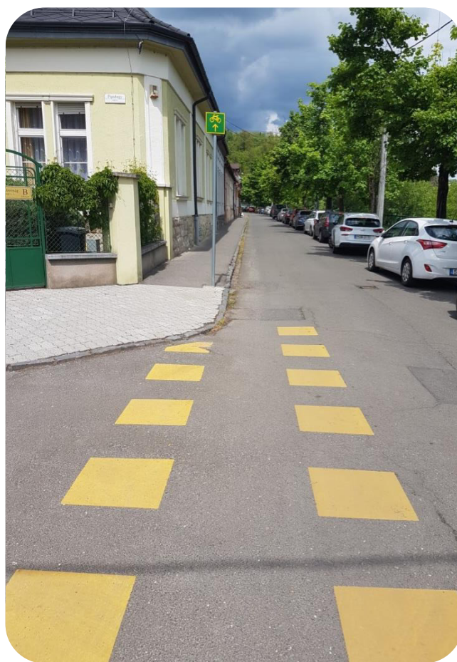
Salgótarján, belváros, Kassai sor kerékpáros nyom kijelölés, piktogramok oldószeres festése felkopott az átvezetések tartós festéke jól állapotú
