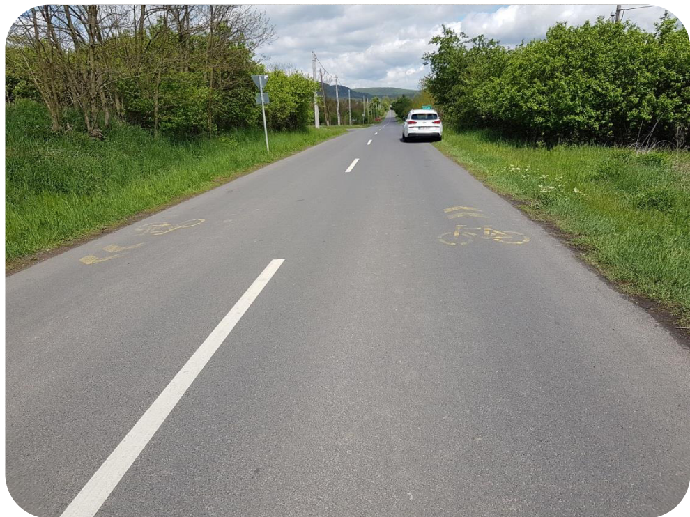
Szentkúti bekötő út (21142 sz. út), lakott területen kívül, kerékpáros nyom piktogramok oldószeres festése felkopott
