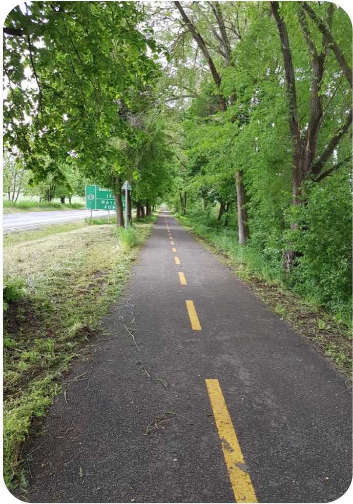
Szécsény, lakott területen kívül, 22 sz. fkl. út útárkon kívül, két fasor között vezetett kerékpárút, természetbarát kialakítással
