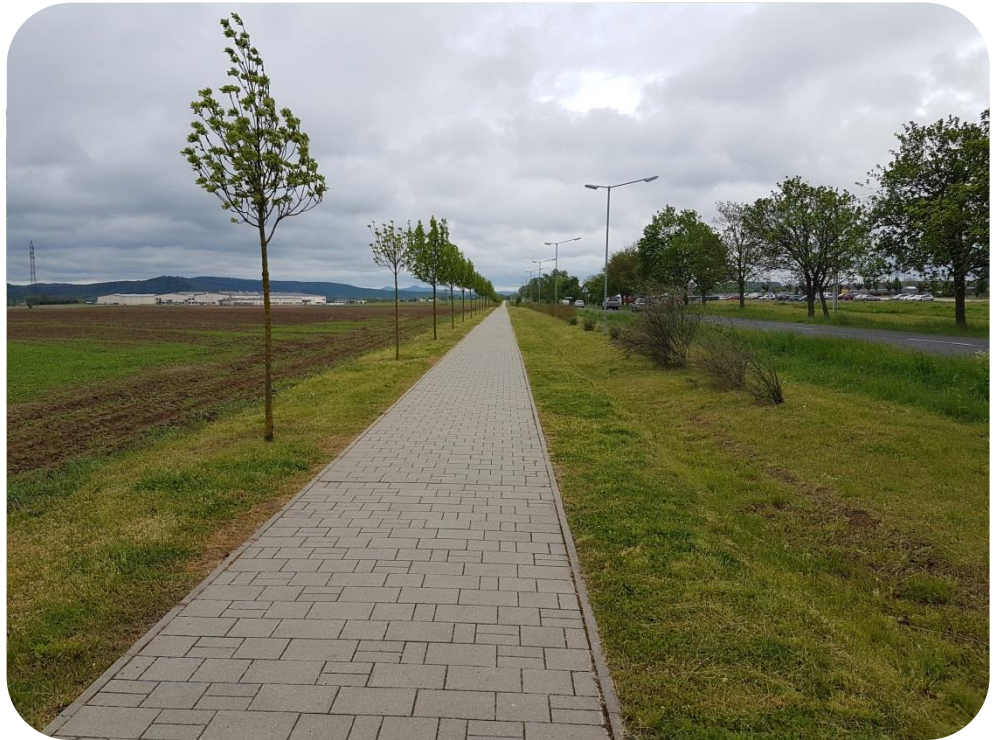
Szügy, lakott területen kívül, 2208 sz. fkl. út útvonalán kívül, fasor és sövény között vezetett kerékpárút, természetbarát kialakítással, közvilágítással ellátva, térkő burkolattal
