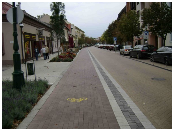
Közút melletti kétirányú kerékpárút
