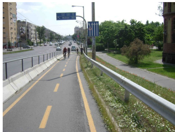
Közút melletti kétirányú kerékpárút
