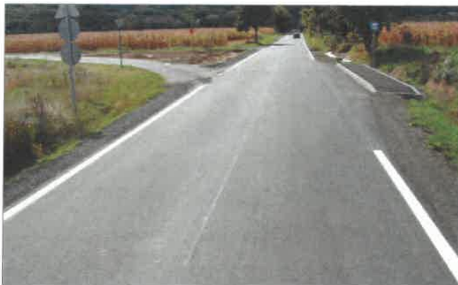
2124-es jelű Cserhátaláp–Szanda összekötő út 7+000–8+000 km szelvények közötti szakaszán végzett felújítás utáni állapota
