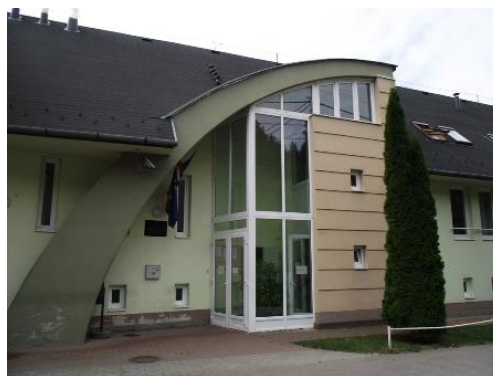
3100 Salgótarján, Karancs út 54. szám alatti épület
